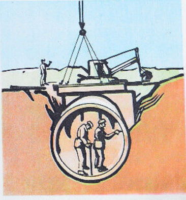
Железобетонные кольца, используемые при строительстве укрытий
